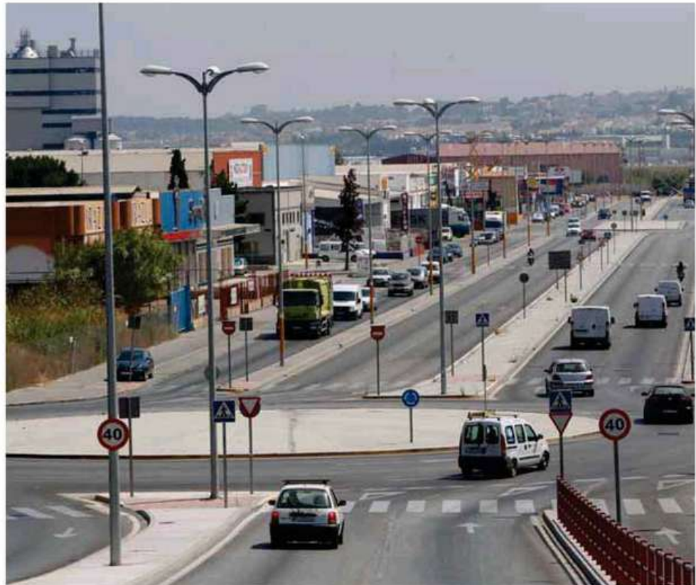
Los dispositivos se instalarán en la carretera Azucarera-Intelhorce. :: RITO SALAS
