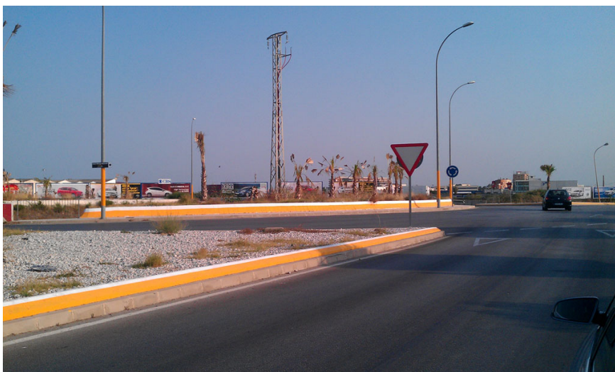
Trabajos de pintura para mejoras varias zonas.
