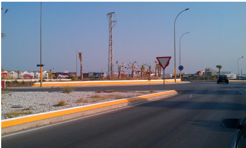
Trabajos de pintura para mejoras varias zonas.
