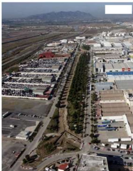
Vista aérea del polígono Guadalhorce. Gregorio Torres
